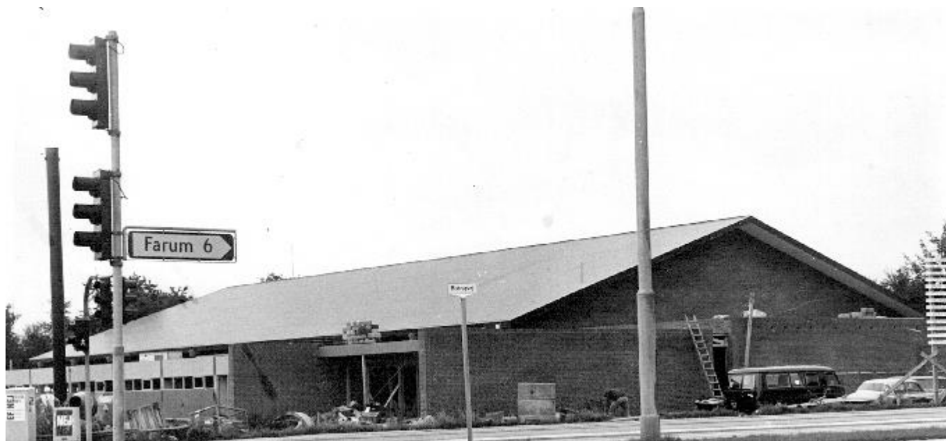
Søndervangshallen som blev opført i 1972 er fortsat en stor del af det samlede Idrætscenter i Birkerød.
